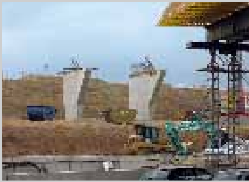
Brückenpfeiler einer Autobahnüberführung
