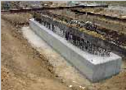
Pfahlkopfbalken bei Mittelpfeiler
