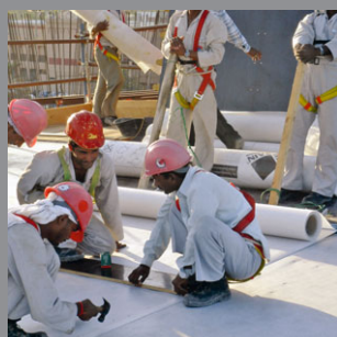
Al Garhoud Bridge Dubai (UAE), 2007
